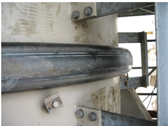
Vervormde balg in behuizing warmtewisselaar
