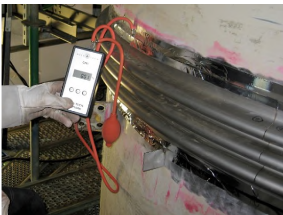
Metten van zuurstof voor aanvang lassen
