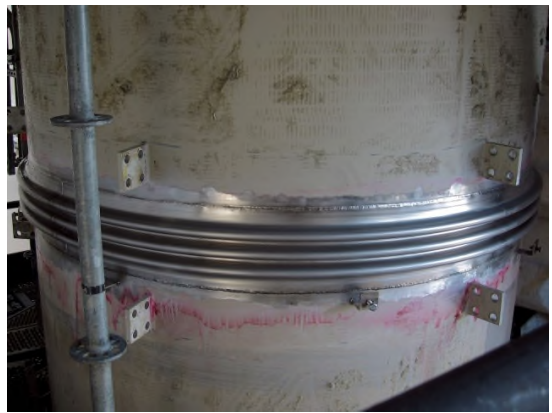
Eindresultaat: warmtewisselaar met nieuwe balg
