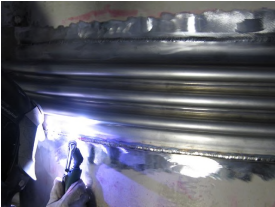
Lassen van balg aan warmtewisselaar
