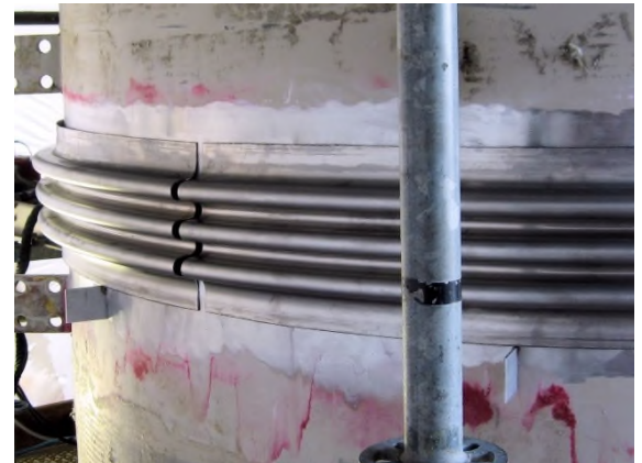
Clam shell geplaatst op warmtewisselaar
