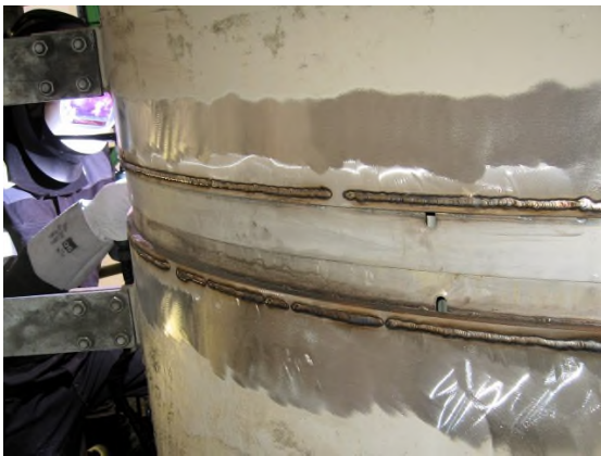
Vorbereiding van behuizing warmtewisselaar
