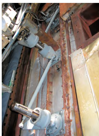
Nieuwe aandrijvingen geleverd en in situ gemonteerd
