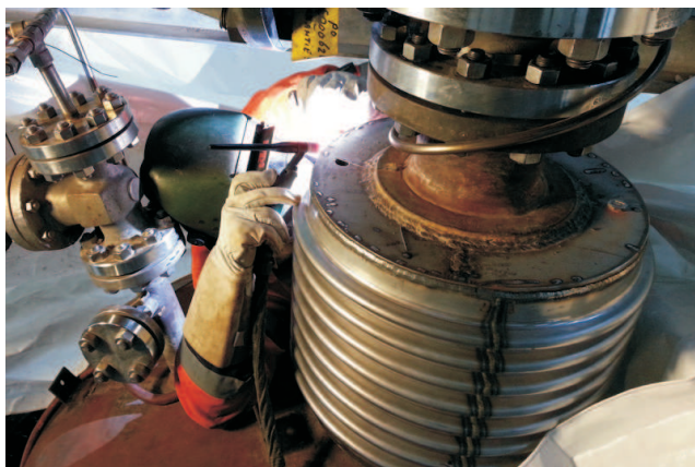
Lassen van de Clam Shell balg
