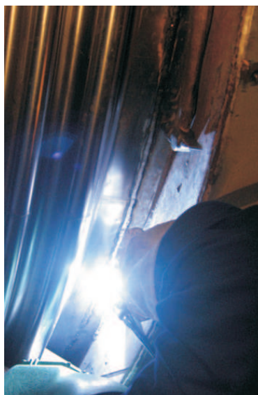
Na demontage lekke compensator wordt nieuwe balg in warmtewisselaar gelast
