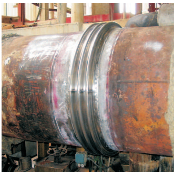
Nieuwe compensator gereed. Na alle testen kan warmtewisselaar weer in gebruik genomen worden
