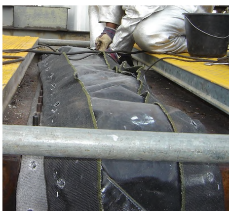
Montage nieuwe weefsel compensator
