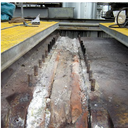
Weefsel compensator gedeeltelijke gedemonteerd
