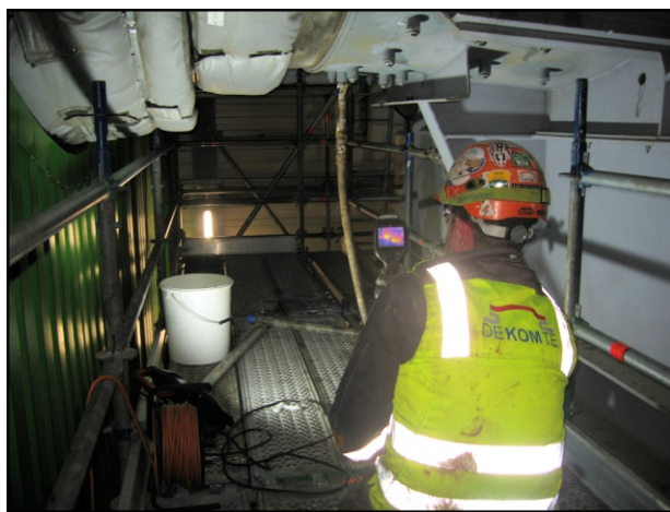
Injectie van isolatie en controle met IR camera
