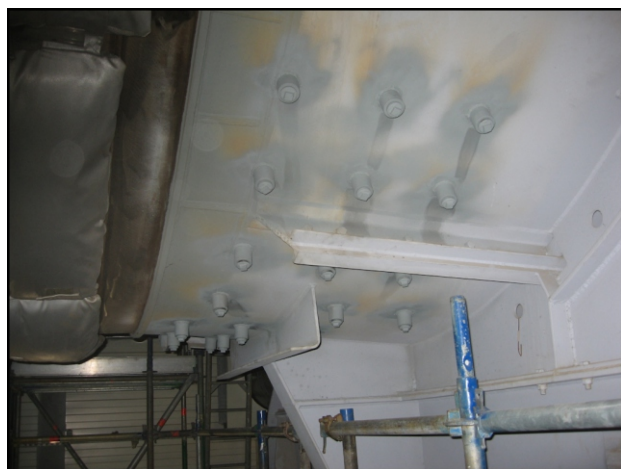
Vorbereidingen voor injectie vloeibare isolatie
